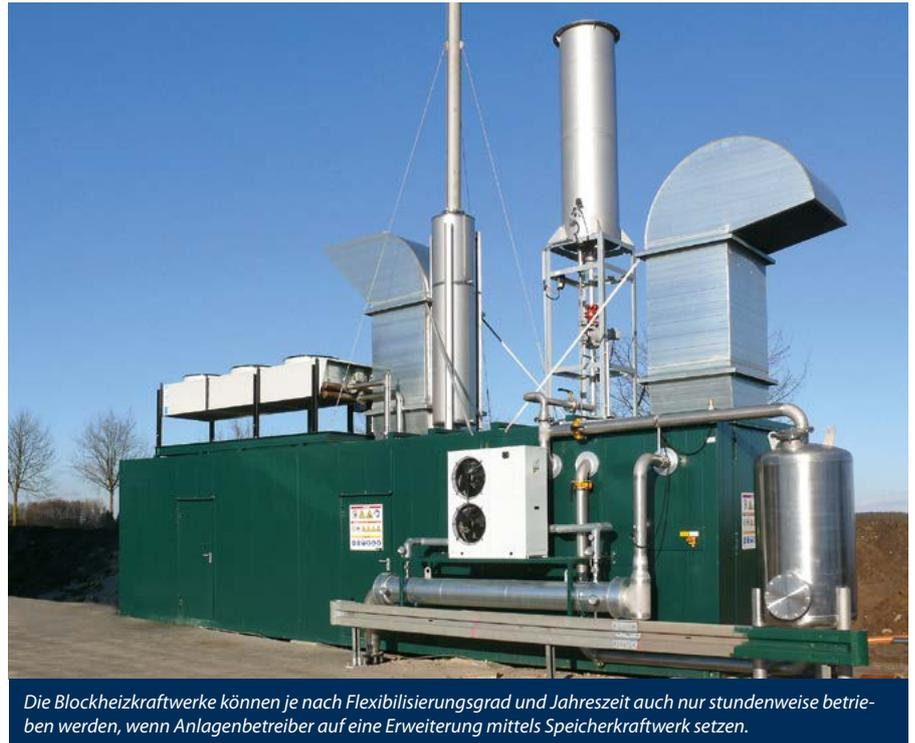
Die Blockheizkraftwerke können je nach Flexibilisierungsgrad und Jahreszeit auch nur stundenweise betrieben werden, wenn Anlagenbetreiber auf eine Erweiterung mittels Speicherkraftwerk setzen.
