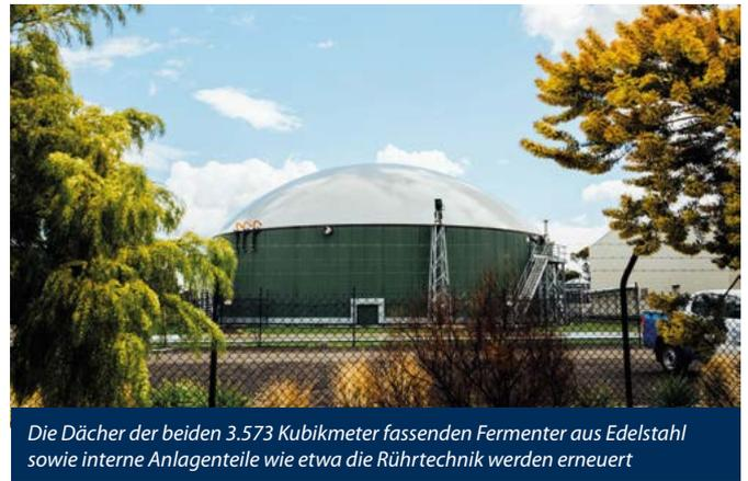
Die Dächer der beiden 3.573 Kubikmeter fassenden Fermenter aus Edelstahl sowie interne Anlagenteile wie etwa die Rührtechnik werden erneuert
